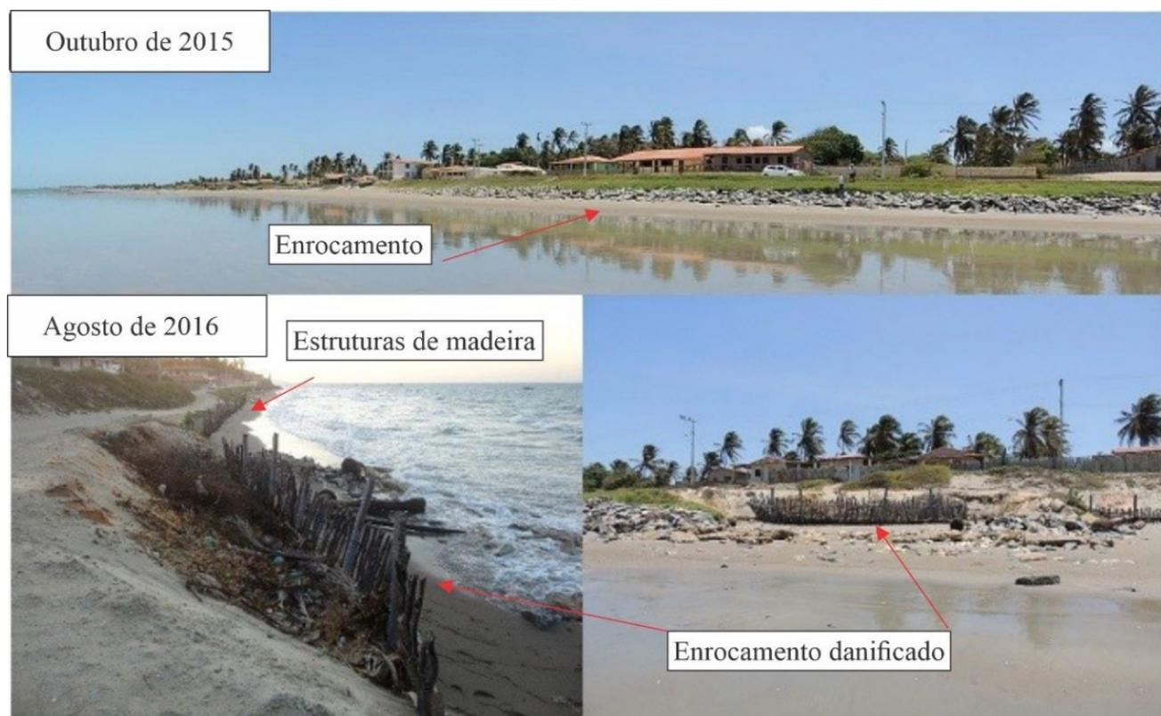
**Figura 6.** Enrocamento instalado no P4 e danos à sua estrutura causadas por alterações nos processos hidrodinâmicos locais na Área de monitoramento 1. **Fonte:** Elaboração dos autores.
