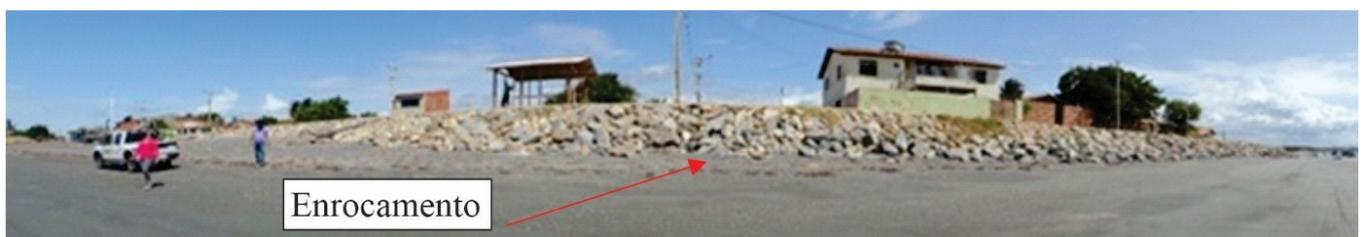
**Figura 10.** Enrocamento instalado na Praia da Barrinha, Icapuí.
