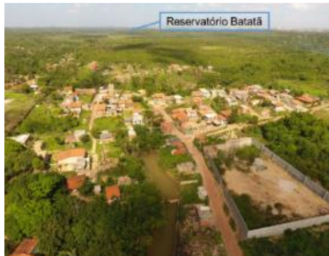
Figura 7 - Canal de primeira ordem represado na sub-bacia do Batatã. Destaque ao fundo no Reservatório Batatã
