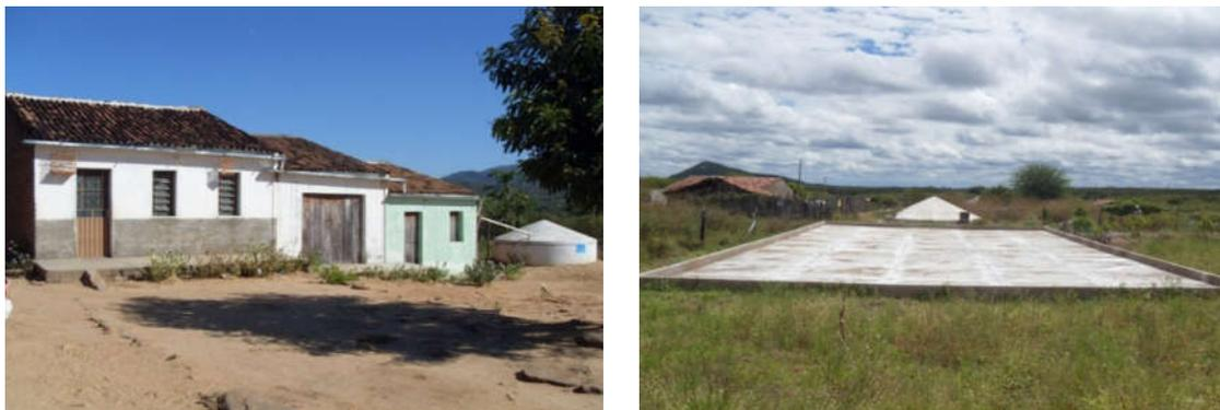
**Figura 2: Cisterna de calha adotada no “Programa Um Milhão de Cisternas” (à esquerda) e cisterna calçada, adotada no “P1 + 2” (à direita).** Fonte: Fotos de Fernando Borges Filho, agosto de 2010
