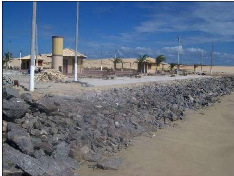
**Figura 7: Enrocamento arrumado de pedras construído na Praia de Mundaú, no Município de Trairi.**
