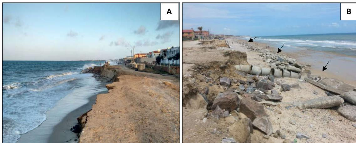
Figura 2: A) Trecho costeiro do Icarai sob forte erosão marinha em fevereiro/15; B) As setas indicam os degraus do *Bagwall* que foram destruídos pela ação da agitação marítima local em fevereiro/15.
