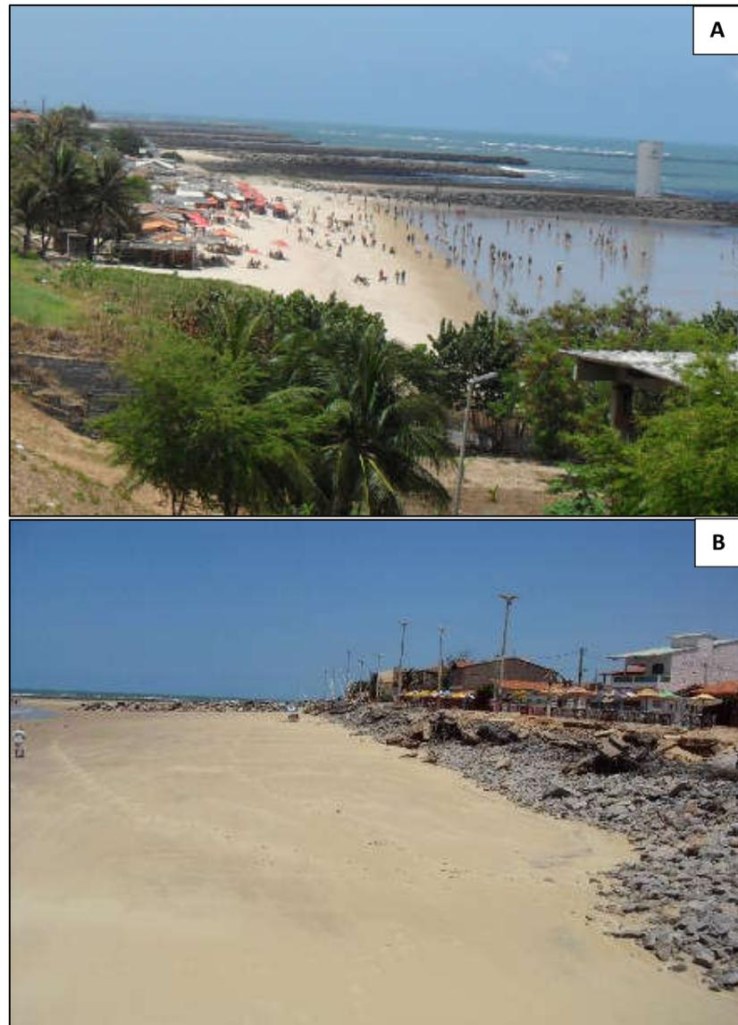
**Figura 5: Obras de proteção costeira identificadas ao longo do LRMF. A) Bateria de espigões na região do Pirambu, em Fortaleza; B) Enrocamento e espigão construídos na Praia da Caponga, em Cascavel.**
